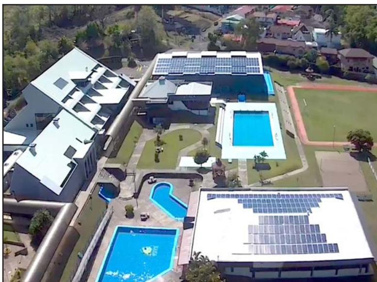
La UACA instaló en la Sede Central 536 paneles solares de 330 watt pico top de línea (jinko solar), de los cuales fueron instalados 400 paneles sobre el techo del gimnasio multiuso y 136 en el gimnasio de pesas, todos conectados a generación distribuida. El proyecto fotovoltaico es un convenio entre la UACA y la Empresa Graviton. La UACA siempre de pionera.
